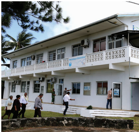
Médiathèque universitaire et base scientifique avancée (rez-de-chaussée) à Wallis.
